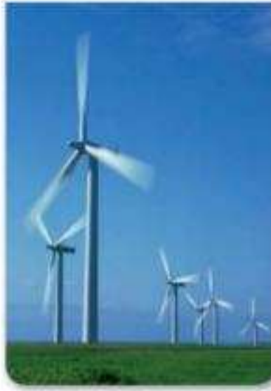
الشكل 7 تنسب المسهولة غير المتساوية لمساح الأرض هبوب الرياح. مما يزيد هذه التربينات بالطاقة ويولد الكهرباء.
